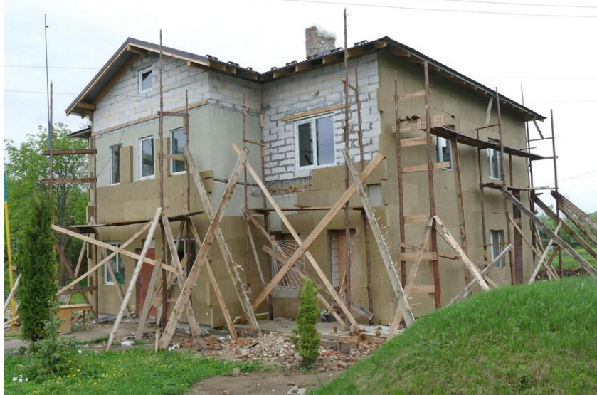
Фото: Ремонт адмін. будівлі Витвицької с.р. ОТГ
