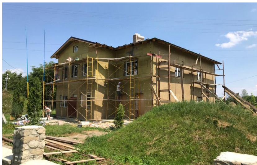
Фото: Капітальний ремонт адмін. будівлі Витвицької ОТГ
